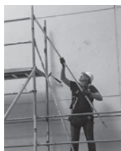
Insérer les 2 lisses dans les clips fermés
