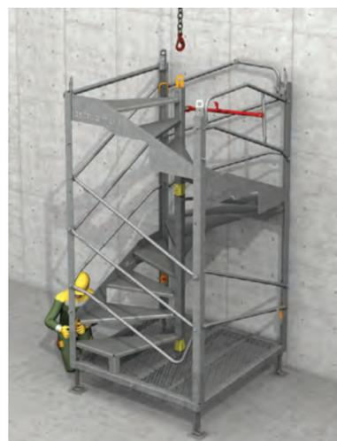
> **3** - Pose du module sur l'embase. Assemblage des 4 montants avec les vis M24 imperdables. Décrochage de l'élingue.
