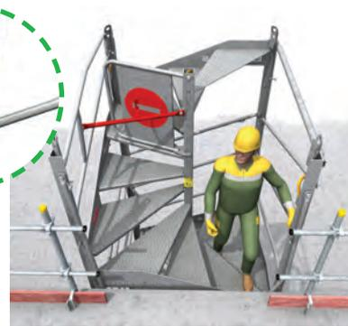
> **8** - S'assurer que les amarrages sont installés avant le décrochage des élingues. Basculement des garde-corps pour permettre la sortie au niveau souhaité.
