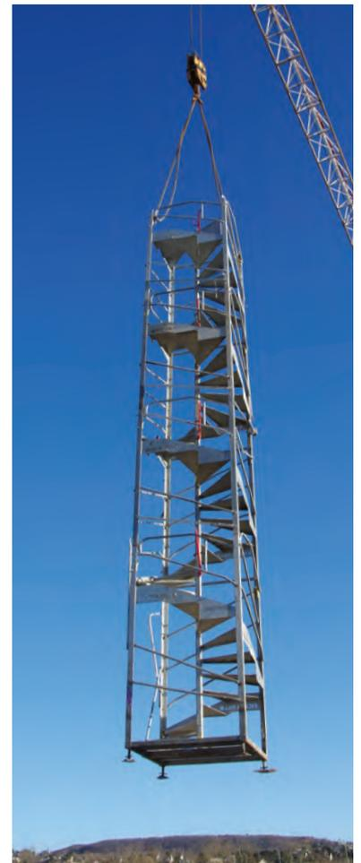
Levage à la grue d'un Escalib Mills.
