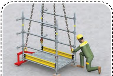
> La traverse et les supports passerelle peuvent être remplacés par le "Support passerelle MDS" mais l'installation nécessite également le port des harnais. Il doit être prémonté avec la passerelle en échafaudage.
