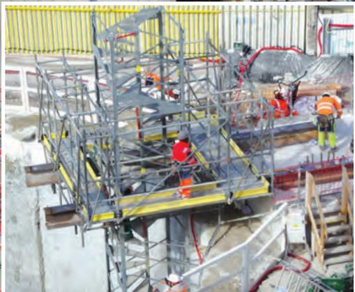
L'Escalib Mills est suspendu sur une charpente en porte-à-faux équipée d'une plateforme de circulation en échafaudage.
