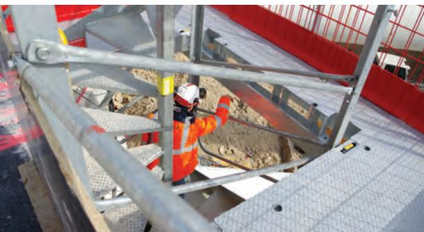
L'Escalib peut être aussi directement en appui sur la plateforme équipée d'un podium (grutable) pour fermer la trémie.
