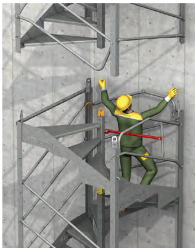
Pose ou dépose d'un module.
