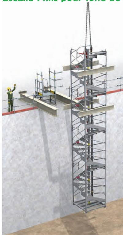
> **2** - Mise en tension des élingues de la grue. Démontage des amarrages et levage de l'ensemble.
