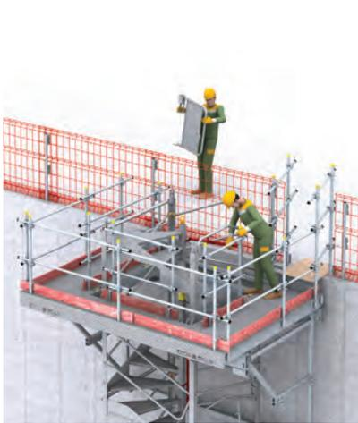
> **1** - Démontez le garde-corps de fermeture. La lisse de montage doit rester en position fermée.
