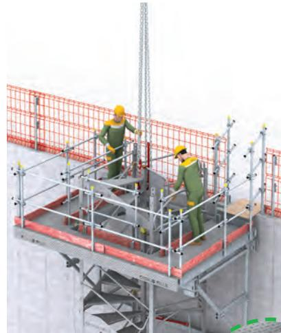
> **6** - Descendre l'Escalib Mills de façon à mettre en contact les sabots du nouveau module sur la plateforme (ou les corbeaux sur les curseurs pour les sabots réglables). Assembler à nouveau les chapes d'amarrages aux montants de l'Escalib Mills. Retirer les élingues depuis la plateforme.
