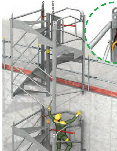
> **7** - Avec les élingues accrochées aux 2 anneaux de levage, pose du module de tête. Assemblage des 4 montants avec les vis M24.
