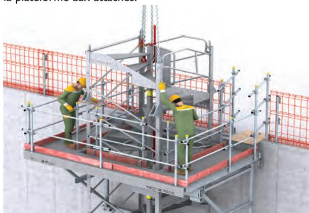
> **6** - Positionner l'Escalib Mills jusqu'à ce que les sabots soient en appui sur la plateforme (ou les corbeaux sur les curseurs pour les sabots réglables). Amarrage de l'Escalib Mills à la paroi (voir Technique & Résistance), à l'aide des chapes d'amarrage et des colliers Escalib Mills.
