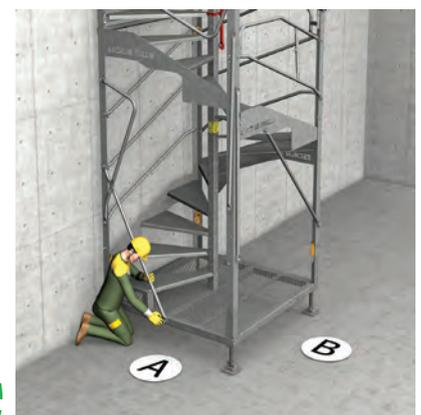
> **5** - Au niveau des entrées, positionnement des lisses en privilégiant l'entrée principale face A (les faces sont repérées sur l'autocollant).
