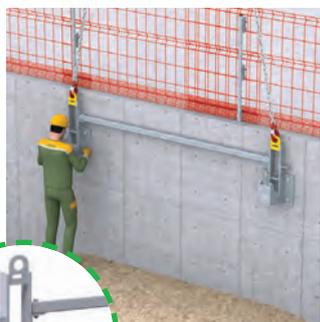
> **1** - Mise en place des attaches sur la paroi. L'entretoise facilite le positionnement. Diamètre des trous de la platine : 31 mm.
