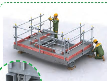
> **2** - Au sol, pose des potelets et des lisses garde-corps en périphérie et autour de la trémie. Puis déverrouiller les bracons en retirant les boulons. Les conserver pour l'étape 3.
