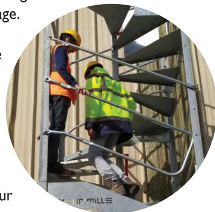
L'Escalib Mills est déplaçable à la grue (8 modules maxi.). Son faible encombrement facilite son installation. Le Mini Escalib Mills (1 m28x1 m28) est conçu pour les chantiers les plus exigus. Des plateformes et des passerelles complètent la gamme pour suspendre des Escalib Mills ou pour franchir des obstacles.
